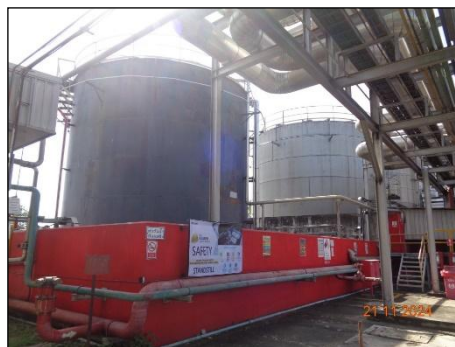
ภาพที่ 2.2-36 คั่นกันรอบถังเก็บ Fuel Oil
