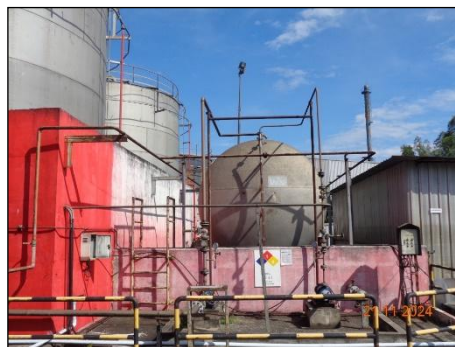
ภาพที่ 2.2-40 คั่นก้นรอบถังเก็บ DEG
