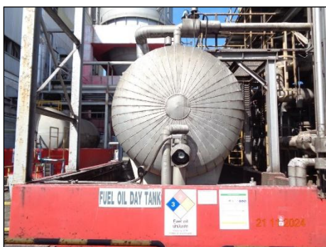
ภาพที่ 2.2-37 คั่นกันรอบถังเก็บ Fuel Oil Daily Tank
