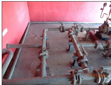
ภาพที่ 2.2-34 วาล์วปิด-เปิด ท่อสารเคมี ที่อยู่นอกคั่นกันสารเคมี
